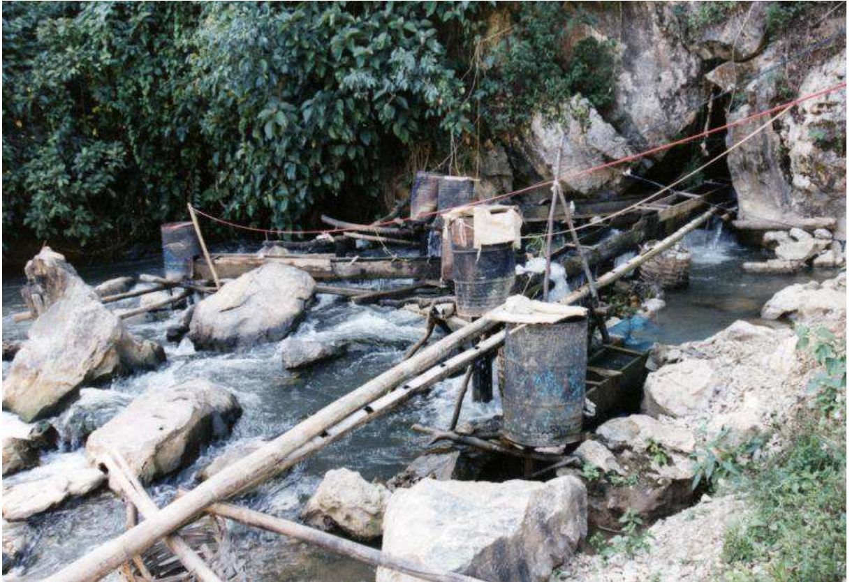
Hình 2 – Một hệ thống thủy điện pico thủ công (Nguồn : Wikipedia)
